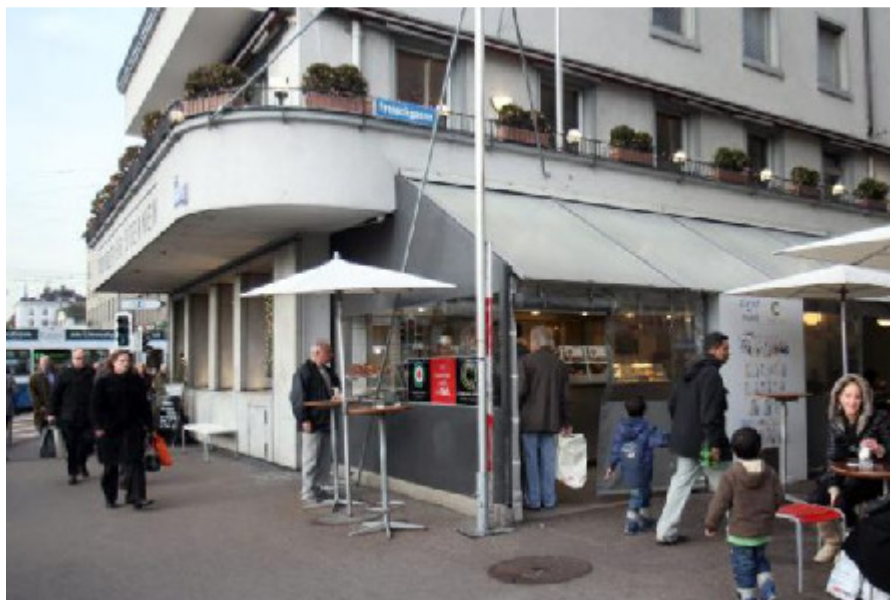
Ehem. Wurststand, Rest. Vorderer Sternen, Theaterstr. 22, 8001 Zürich
